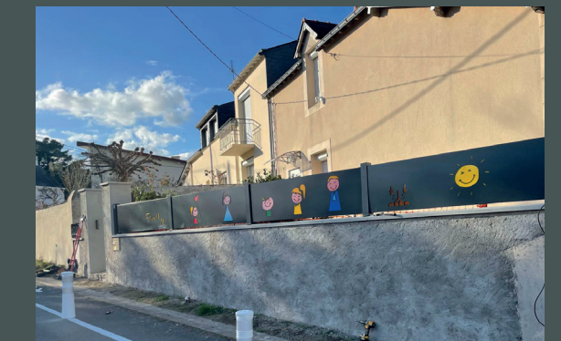
Mur béton existant
